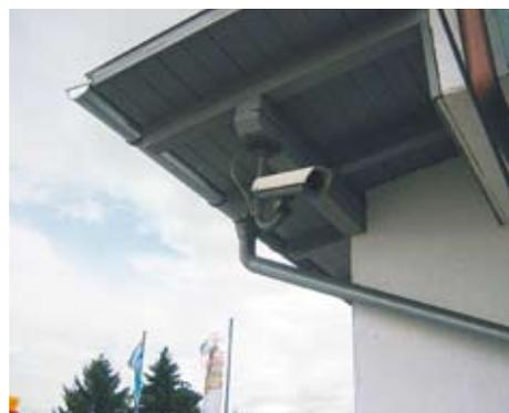
**Liegen die Entfernungen zwischen Kamera und Monitor über 150 Meter, so ist die Signalübertragung mit Zwei-Draht-Leitung eine gute Alternative. Hier lassen sich Reichweiten von ein bis zwei Kilometer realisieren**
