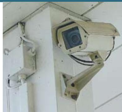
**Koaxialkabel (RG59) sind bei Reichweiten bis zu 150 Meter die preiswerteste Verbindung. BNC-Anschlüsse sind auf fast allen Geräten für Video-Überwachung vorhanden**
